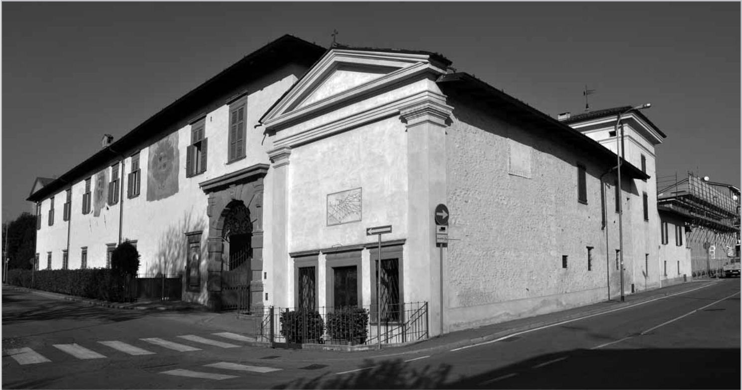
La villa Celadina prospetto a meridione South-facing facade of Villa Celadina
